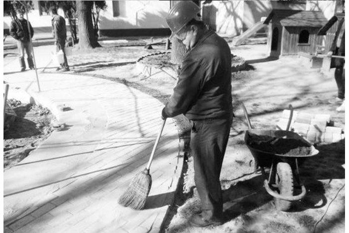
A közmunka program viacoloros csapata lerakta a Széchenyi úti óvoda homokozója köré a járdát. Továbbá megkezdődött a Deák úti óvodában a megsérült betonjárda cseréje.
